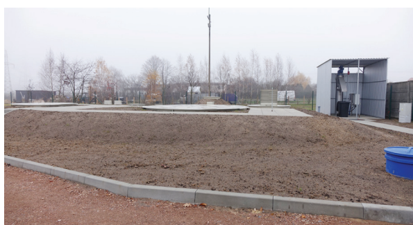
Oczyszczalnia ścieków w Zawadach (listopad 2019)
