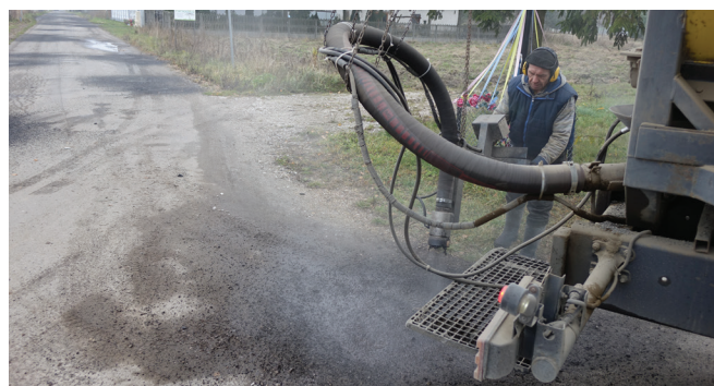
W ramach bieżącego utrzymania dróg prace toczyły się m.in. na drodze w Dobrzelowie - Parasolce
