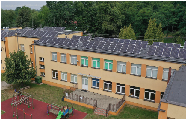
Instalacja fotowoltaiczna na dachu Szkoły Podstawowej w Dobrzelowie
