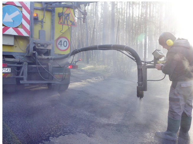
Remont drogi gminnej Łękawa - Słok (listopad 2019)
